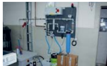
Das Reinwassersystem ermöglicht Druck ohne chemische Zusätze.
