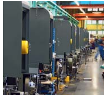
Ebenfalls eine Ausbildungsstation: die Taktbandmontage der Roland 700 Evolution im Werk 2 von manroland sheetfed Offenbach.
