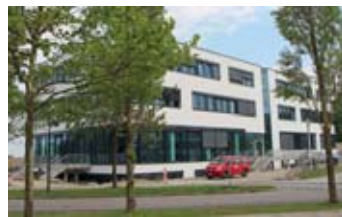
Das neue Institutsgebäude der Fogra in Aschheim bei München.
