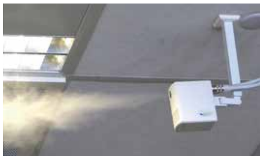
Mikrofeiner Sprühnebel des Draabe NanoFog-Luftbefeuchters.
