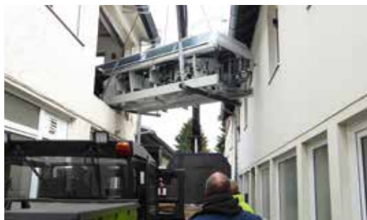
Die Einbringung des Klebebinders City e in den ersten Stock durch ein ausgebautes Fenster war Millimeterarbeit.
