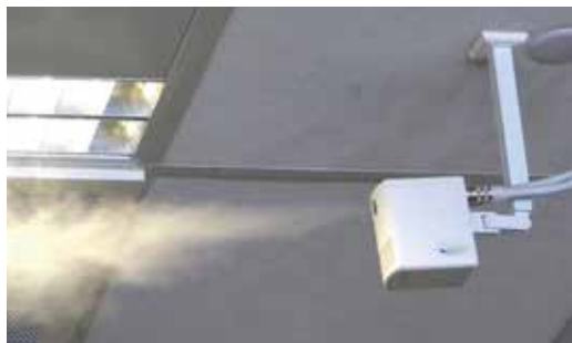
Mikrofeiner Sprühnebel des Draabe NanoFog-Luftbefeuchters.
