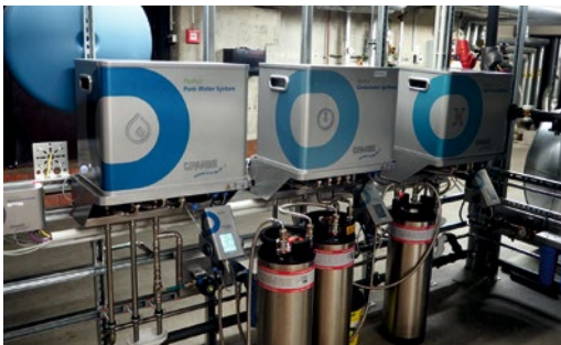
Mehrstufige Wasseraufbereitung in mobilen Kleincontainern.
