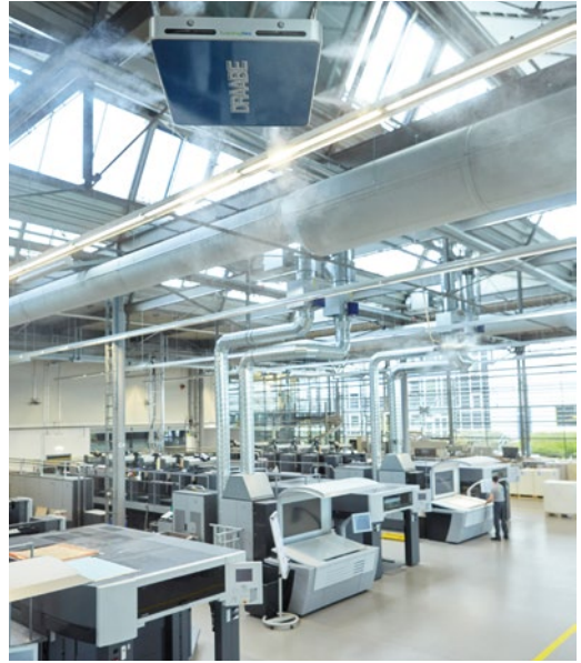
Energieeffiziente Luftbefeuchtung und Kühlung: Hochdruck-Luftbefeuchter im Einsatz.
