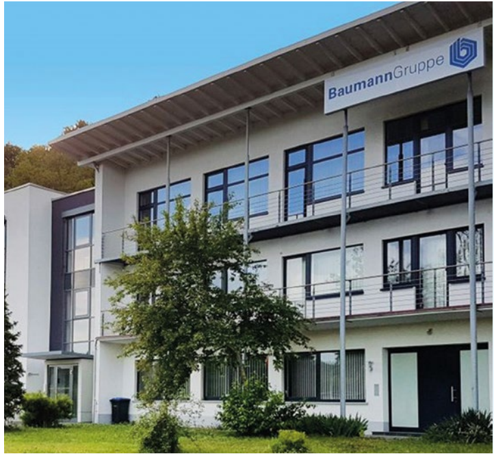
In Solms, dem Hauptsitz der Baumann-Gruppe, laufen seit Wochen die Vorbereitungen für die Eröffnung des ersten Komori-Kompetenzzentrums in Europa.
