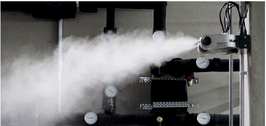
Der Luftbefeuchter Draabe TurboFogNeo.
