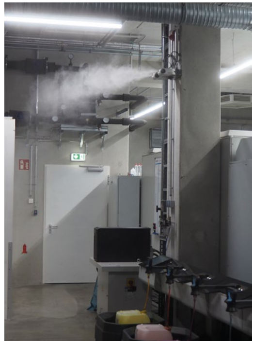
Individuell positionierbar: der Hochdruckbefeuchter TurboFogNeo.
