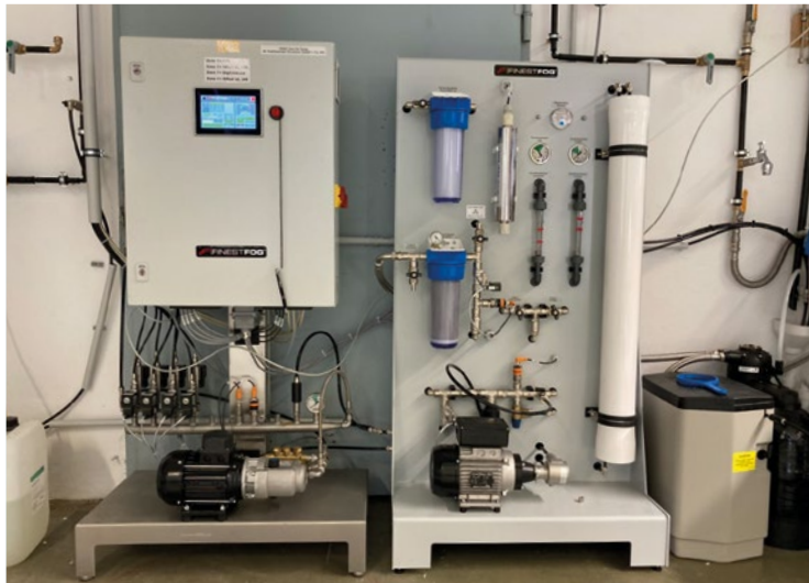
Die kombinierte Wasseraufbereitungs- und Luftbefeuchtungsanlage von Finestfog bei Kohlhammer ist kompakt sowie übersichtlich und schafft ein gutes Klima.
