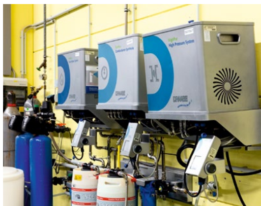
Die transportablen Container der Condair Wasseraufbereitung werden halbjährlich zur Wartung ausgetauscht.
