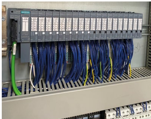
Blick auf eine umgebaute und erneuerte Steuerung nach dem aktuellen Siemens S7-Standard. Die Software für die Steuerung wurde von QTM selbst programmiert.
