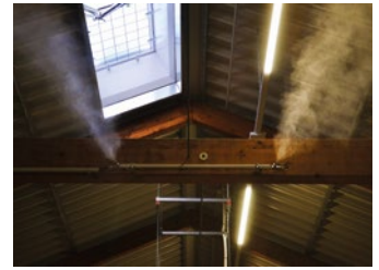
Oben: Die Luftbefeuchtung in der Wellpappe-Zone.
