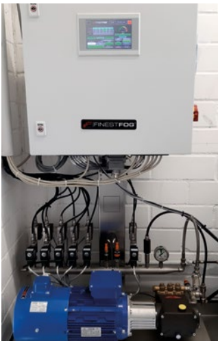
350 Liter Wasser verteilt die Luftbefeuchtungsanlage von Finestfog pro Stunde auf 7.000 Quadratmeter Fläche und sorgt so für perfektes Klima.
