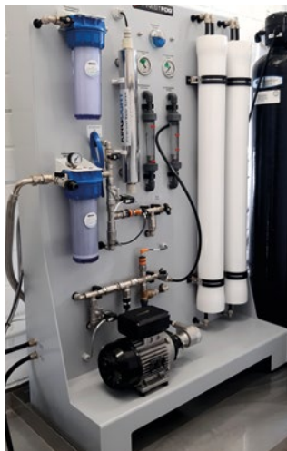
350 Liter Wasser verteilt die Luftbefeuchtungsanlage von Finestfog pro Stunde auf 7.000 Quadratmeter Fläche und sorgt so für perfektes Klima.
