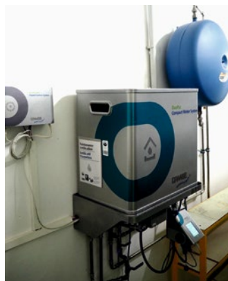
Das Condair System für die Wasseraufbereitung wird zur Wartung und Reinigung alle sechs Monate automatisch getauscht.
