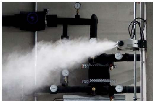
Direkt-Raumluftbefeuchter mit Hochdruckdüsen haben einen geringen Energiebedarf und kühlen zusätzlich.
