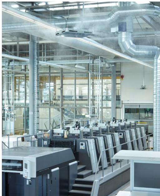
Eine kontrollierte Luftfeuchte schützt vor Elektrostatik und Qualitätsschwankungen.
