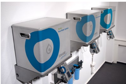
Das Condair-System „Draabe Pur“ für die Wasseraufbereitung wird zur Wartung und Reinigung alle sechs Monate automatisch getauscht.
