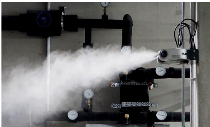
Hochdruck-Düsen-Luftbefeuchter haben einen geringen Energieverbrauch.
