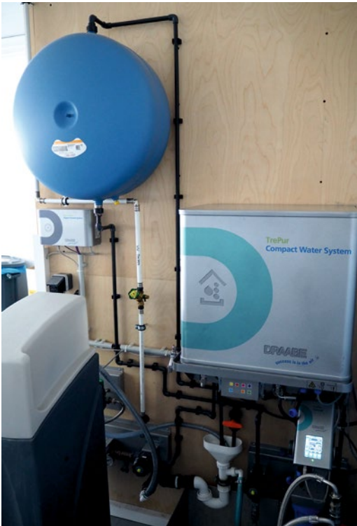
Draabe-Wasseraufbereitung im mobilem Service-Container, der halbjährlich zur Wartung getauscht wird.
