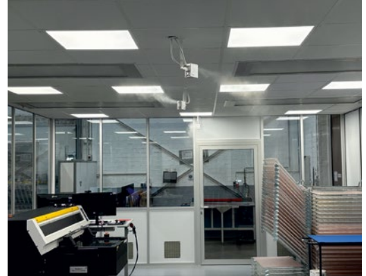
Luftbefeuchtung im Bopla-Digitaldruck unter Reinraumbedingungen.
