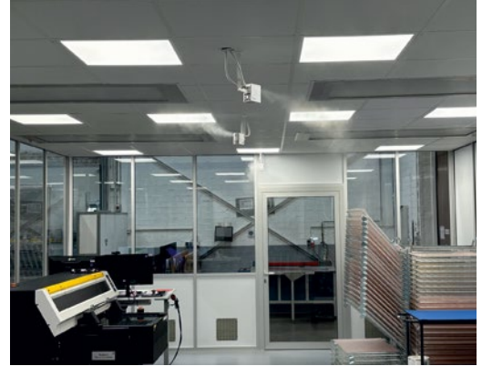
Luftbefeuchtung im Bopla-Digitaldruck unter Reinraumbedingungen.
