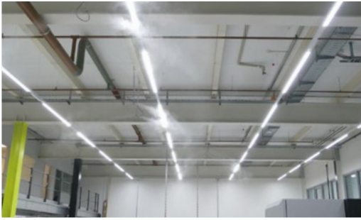
16 Düsen sorgen für eine feine Wasser-Aerosole-Verteilung in der 650 m 2 großen Druckhalle von WmD.
