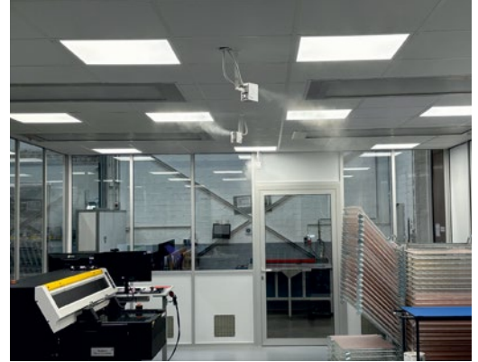
Luftbefeuchtung im Bopla-Digitaldruck unter Reinraumbedingungen.
