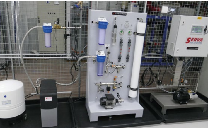
Wenig Platz benötigen Finestfogs Wasseraufbereitung und Steuerung. Hier wird die gesamte Anlage überwacht und gesteuert sowie Daten für den Service geliefert.
