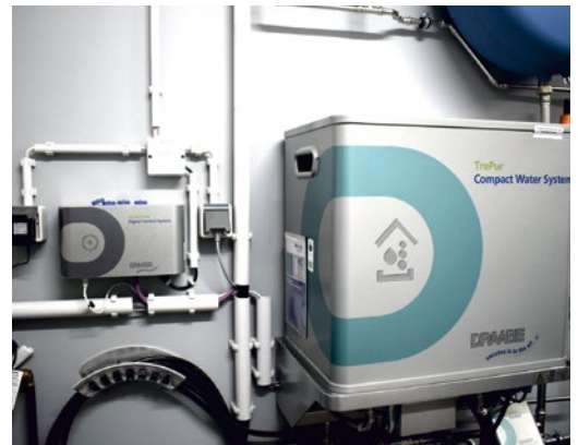
Die kompakte Wasseraufbereitung im kompakten Technik-Modul sichert eine hygienische und mineralfreie Luftbefeuchtung.
