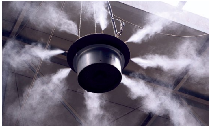
Das Condair ML-Princess-System sichert die optimale Luftfeuchte in hohen Hallen.
