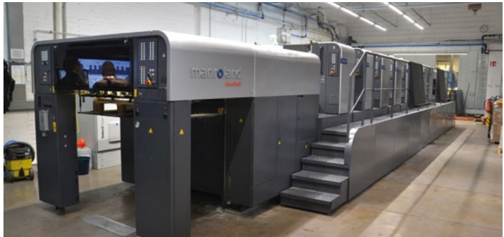
Nachhaltige Investition in Effizienz: die neu installierte, gebrauchte Manroland R708 Evolution im Piereg Druckcenter.
