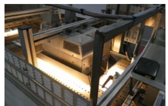
Die vorhandenen IR-Trockner können weiterhin genutzt werden.
