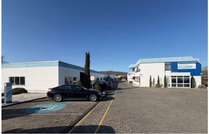
Die Gebäude der Plump Druck & Medien GmbH in Rheinbreitbach. Die vollstufige Druckerei verfügte über leistungsfähige Weiterverarbeitungsoptionen für Bücher und Broschüren.
