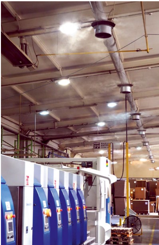
Die Condaire ML-Luftbefeuchtung kühlt zusätzlich und reduziert Staub.
