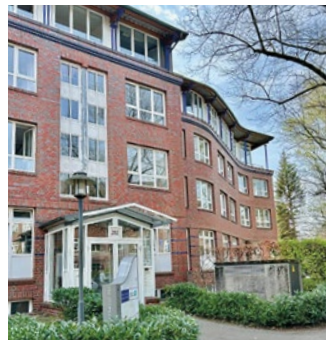
Die Alsterdorfer Straße in Hamburg ist Sitz der Druckerei Weidmann. 1963 erbaut und 1990 erweitert, besitzt das Unternehmen jeweils 1.000 m² Produktions- und Lager-räume, sowie 400 m² für das Büro und die Vorstufe.
