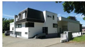
Die Ellenbacher Straße in Kassel ist Sitz der derzeit neun Mitarbeiter starken PMLS GmbH & Co. KG.
