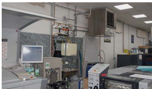
Unter der Drucksaaldecke platziert, sorgt der BiLuVa KL-8702 Kaltluftbefeuchter von Binder für genügend Luftfeuchtigkeit in den 900 m 2 großen Räumlichkeiten.
