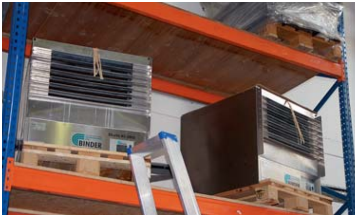
Zwei Geräte des Typs BiLuVa KL-5802 der neuen Generation Binder-Kaltluftbefeuchter für ein Raumvolumen von je 5.800 m 3 wurden bei Henrich einfach auf ein Hochregal gestellt. Von dort versorgen sie die gesamte Halle.
